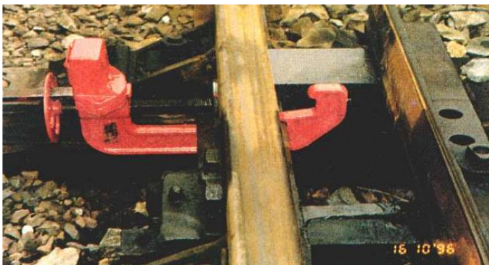
Rys. 4. Iglicę odsuniętą należy zabezpieczyć, gdy zamknięcie nastawcze działa prawidłowo.
